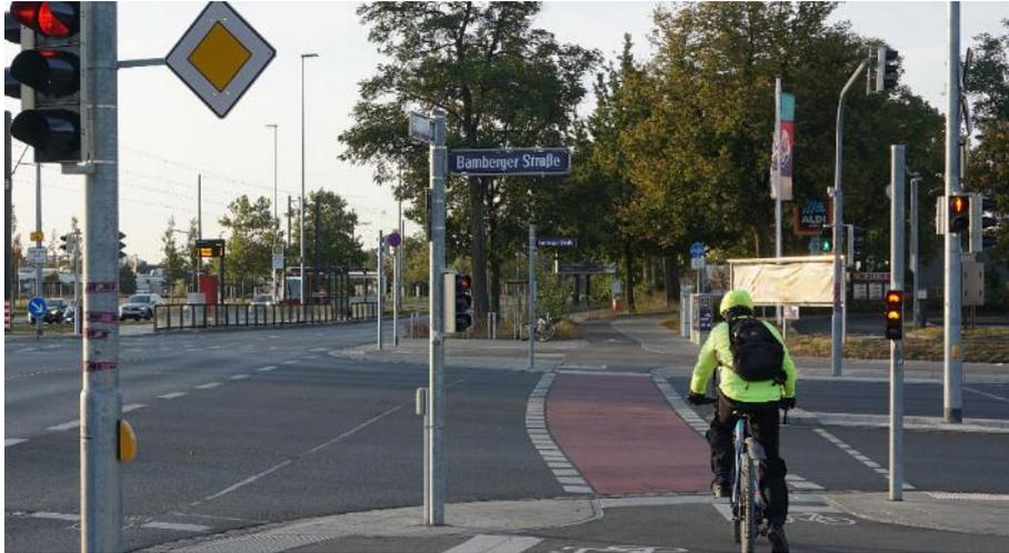
Abbildung 11: Signalisierter Knotenpunkt mit Fahrradampel und Vorlaufgrün
