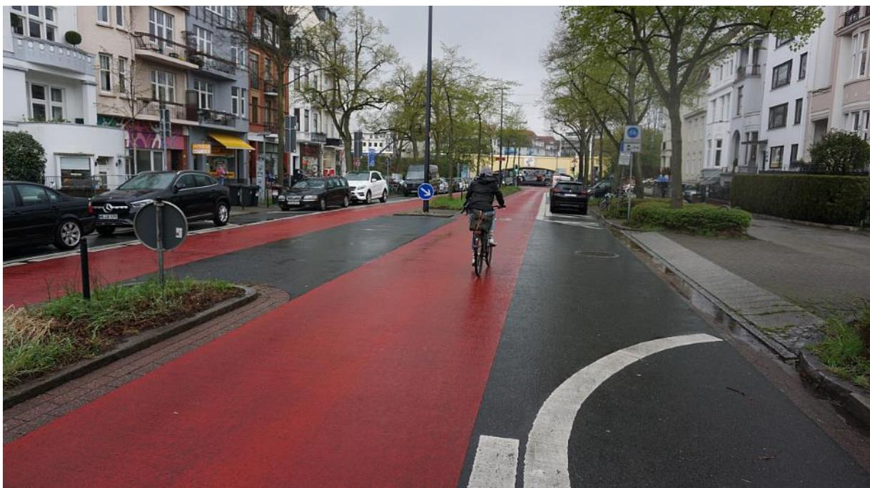
Abbildung 23: Gut gestaltete Fahrradstraße mit Roteinfärbung, wiederholenden Piktogrammen, freigehaltenen Sichtflächen, Gehwegüberfahrt, Sicherheitstrennstreifen
